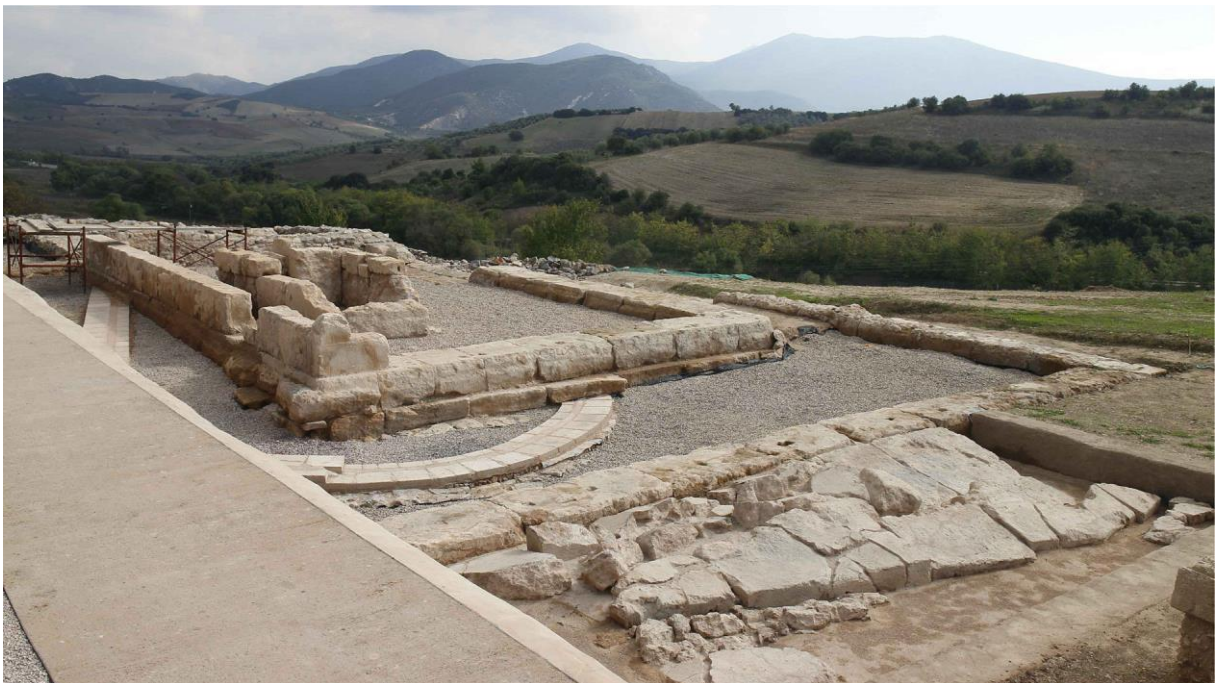
Ιερό Καλαποδίου, το νότιο ναϊκό συγκρότημα κατά τη διάρκεια των εργασιών συντήρησης (2019)
